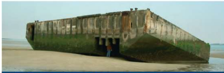
Gedeelte van de drijvende loskade op het strand van Arromanches
